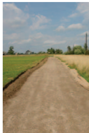
Строительство сельской дороги
