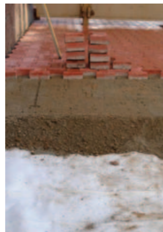
Мощение тротуарной плиткой
