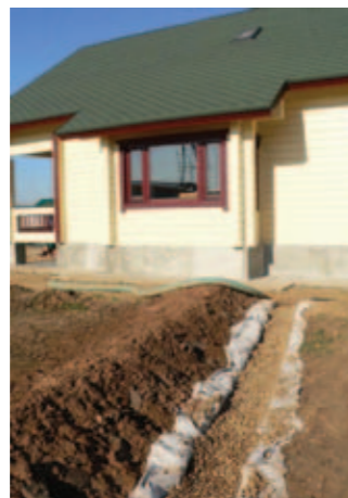
Устройство дренажной системы
