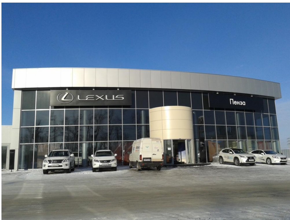
Автосалон «Lexus», система кондиционирования и общеобменной вентиляции, система дымоудаления. Объект введен в эксплуатацию в 2014 г.
