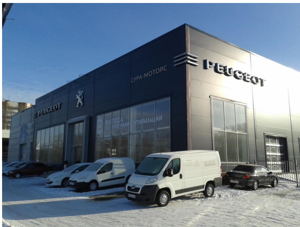
Автосалон «Peugeot», система кондиционирования и общеобменной вентиляции, объект введен в эксплуатацию в 2013 г.
