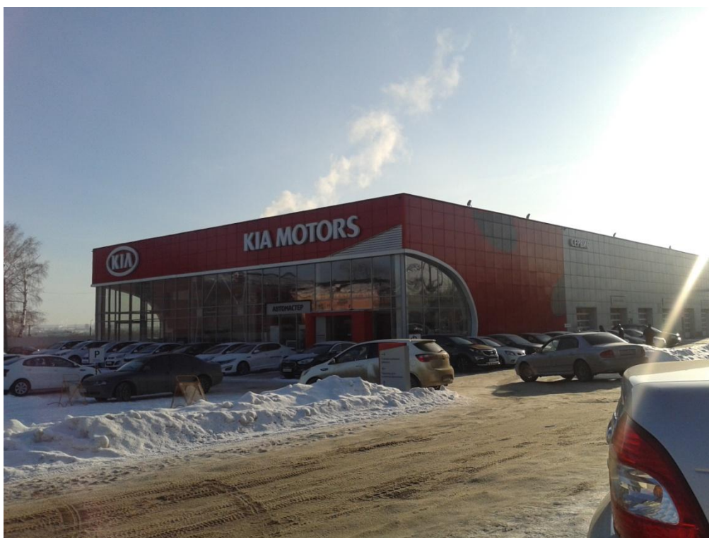
Автосалон «Kia Motors», система кондиционирования и общеобменной вентиляции, объект введен в эксплуатацию в 2012 г.
